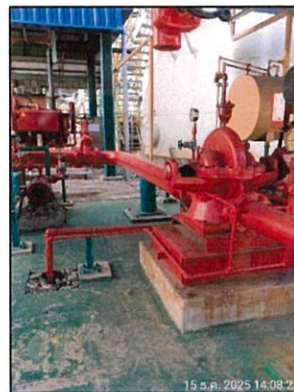
ภาพถ่ายที่ 2.2-35 เครื่องสูบน้ำดับเพลิง
