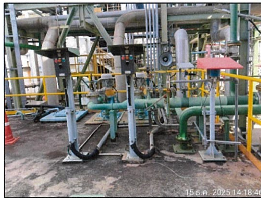
ภาพถ่ายที่ 2.2-13 เครื่องมือตรวจวัดคุณภาพน้ำอัตโนมัติ บริเวณบ่อพักน้ำทิ้ง (Holding Pond)
