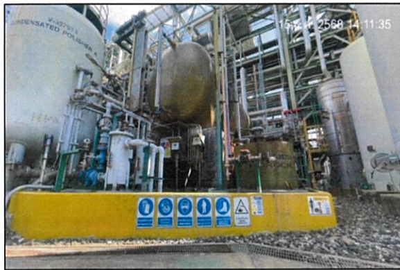
ภาพถ่ายที่ 2.2-33 คันกันล่อมรอบถังเก็บสารเคมีป้องกันการรั่วไหล
