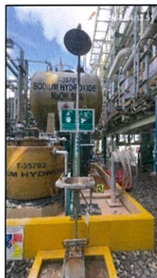
ภาพถ่ายที่ 2.2-31 อ่างล้างตาและฝักบัวฉุกเฉินบริเวณโครงการ
