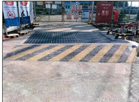
ภาพถ่ายที่ 2.2-16 บ่อรับน้ำฝน (Rain Water Pit)
