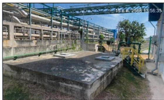
ภาพถ่ายที่ 2.2-3 บ่อพักน้ำทิ้งฉุกเฉิน (Emergency Pond)
