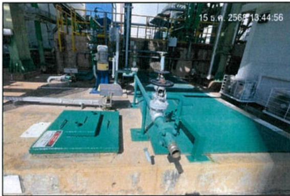
ภาพถ่ายที่ 2.2-15 ถังแยกน้ำ-น้ำมัน (Oil Separator Tank)
