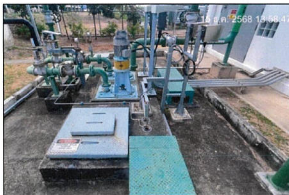
ภาพถ่ายที่ 2.2-46 Emergency Pond Pump
